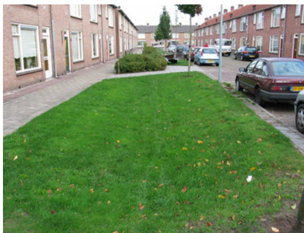
Figuur 3-7 Voorbeeld wadi na aanleg in variant 2.
