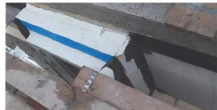
Deze aandacht voor lichtdichtheid: Sollicyten worden afgewerkt met flexibele bouw toe- verkennd, afgesneden en vervolgens ingewerkt of zichtbaar aan de zijkant. Haden op het raam worden afgestapt.
