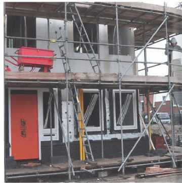
Comfort, energie en milieu – de woningen volgens de Active House-gedachte in aanbouw
